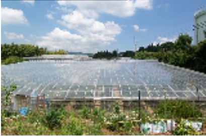
レディヒート吹付け前
