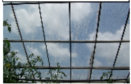
吹付け後、内側から外を見ると
