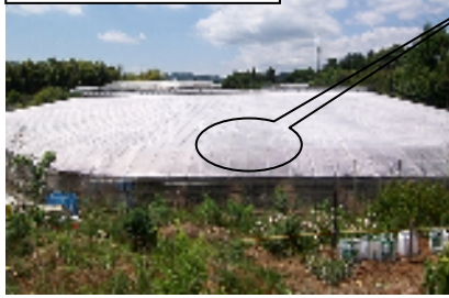
レディヒート吹付け後
